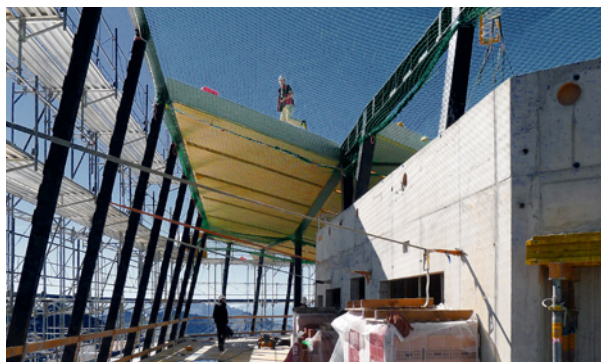
Das Gipfelrestaurant auf dem Weisshorn bei Arosa (CH) ist ein Mischbau aus Beton, Stahl und Holz. Die Holzbau-Elemente sorgen im Wesentlichen für die Aussteifung der Stahlkonstruktion bzw. des gesamten Gebäudes.
