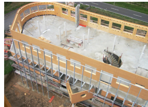
Das Bürogebäude des Heizkesselherstellers ÖkoFen im bayerischen Mickhausen ist ein Mischbau aus Stahlbeton-Stützen und -Decken sowie vorgefertigten Holzrahmenbau-Außenwand-Elementen.
